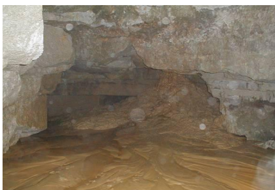
Comblement par coulis de silicates
