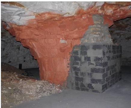
Reprise d'un pilier par maçonnerie
