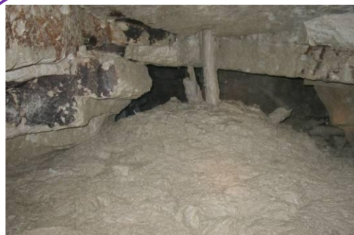
Comblement par déversement gravitaire
