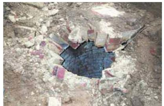
Déboufrage d'un puits vu de la surface
