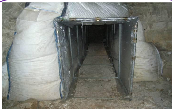
Tunnel édifié à travers de la mousse expansive et permettant de maintenir un passage
